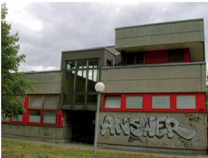
Keine Spur von „Kunterbunt“ – Kita vor der Sanierung
